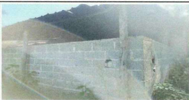
Foto 5: Parte frontal de la escuela el block se encuentra deteriorado y se necesita reparar por paredes de block, ventanas y puerta.
