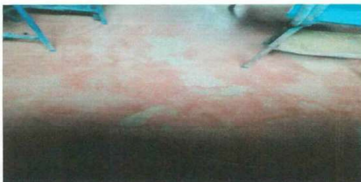
Foto 5: Piso: Mejoramiento de piso por piso ceramico.
