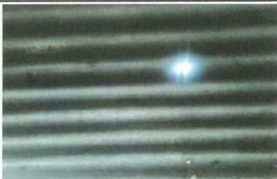
Foto 1: Cubierta de lamina.
